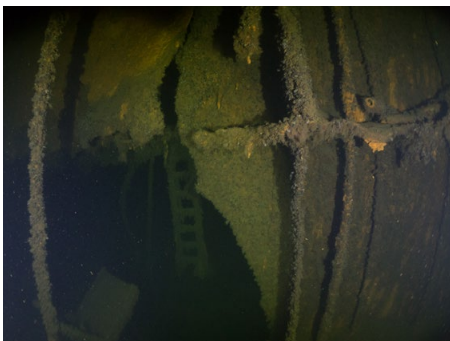
Zdjęcie 17. Rozerwana gródź między zbiornikami pod dziobową nadbudówką (źródło: ekspedycja 2018, fot. M. Czermiński)
